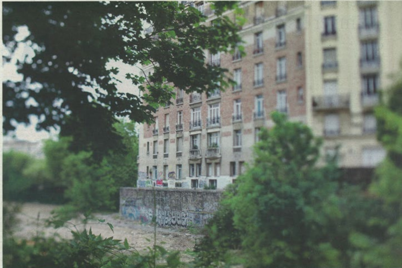
Le chantier du boulevard Suchet (XVI e arrondissement) vu depuis le boulevard de Montmorency, le 13 mai.
