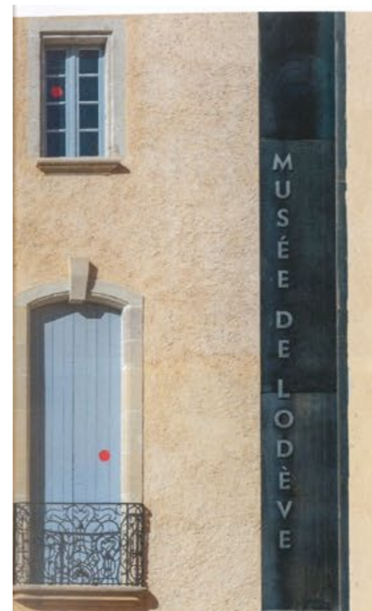
Les balustres en fer forgé du xviii e siècle ont été restaurés ou fabriqués à l'identique par la société Théron. Les enduits à la chaux sont fouettés à la branche de genêt.
