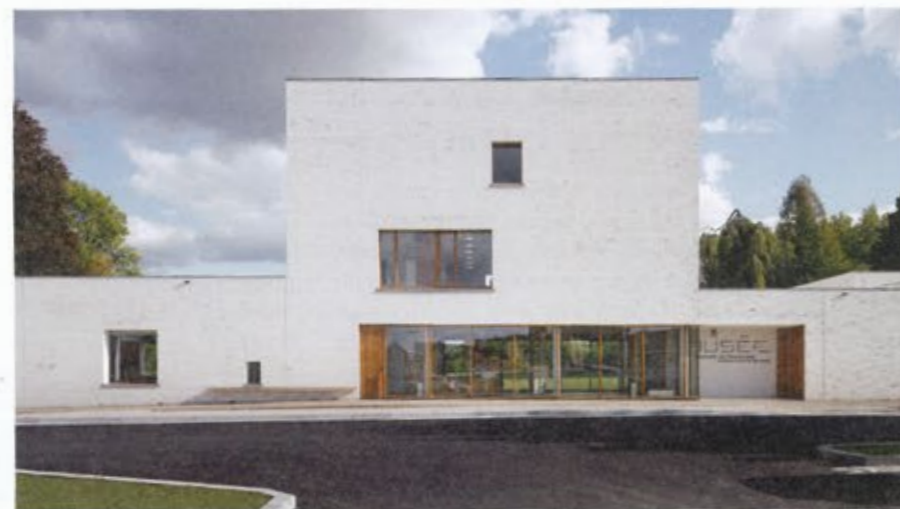
Façade sur la ruelle et le parking.
