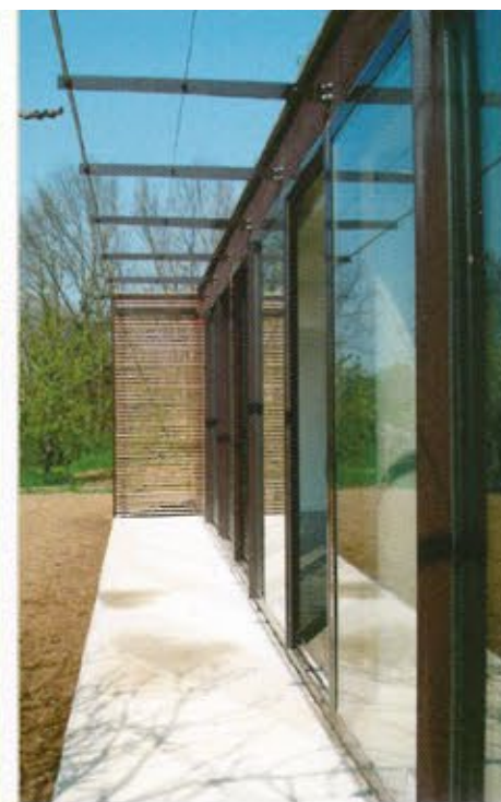
Ci-contre : façade sud. Ton sur ton avec l'écorce des arbres, le bardage horizontal de lamelles d'épicéa rétifé, contribue à alléger et homogénéiser le volume. Il escamote les châssis vitrés en les recouvrant (cf. image du bas, à l'extrême gauche) et se poursuit sur les flancs nord-sud du bâtiment en paroi ajourée.
